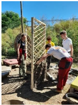
Fot 7 i 8 Wypełnienie ściany mieszanką gliny, piasku, trzciny, wody
