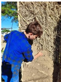
Fot 9. Nakładanie wyprawy tynkarskiej z glin, piasku, trzciny, wody,
