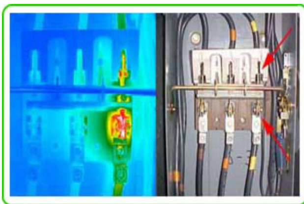
Grzanie się instalacji elektrycznej w skutek niewłaściwego wykonania styków.
