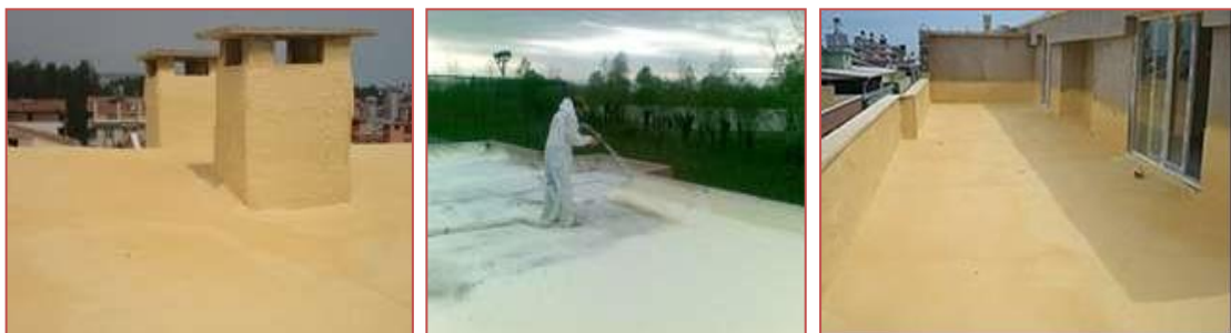
Fot. 2÷4 Metoda natryskowa docieplenia stropodachów pełnych
